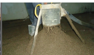
Наша работа скрыта от глаз непосвященных Керамзитобетон
