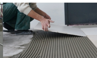
Наша работа скрыта от глаз непосвященных Укладка плитки
